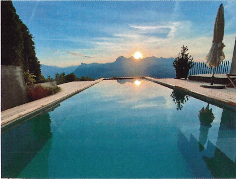
Kompaktbecken bei Ferzigstellung
