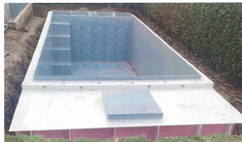
Kompaktbecken beim Einbau
