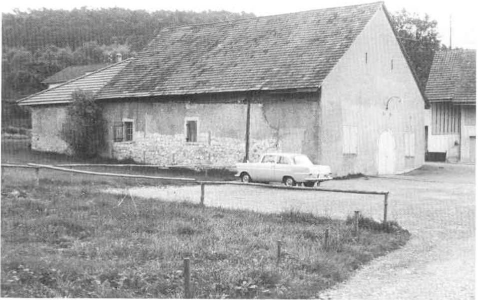
Bild 103. Die ältere der beiden herrschaftlichen Trotten um 1970. Hier befand sich schon im 14. Jahrhundert die trotterbergische Trotte. Der noch bestehende Bau wurde unter Verwendung älterer Teile 1656/57 aufgeführt; er trug bis ins letzte Jahrhundert hinein (1895) einen Strohwalm, die Giebelmauer ist also nicht ursprünglich.
