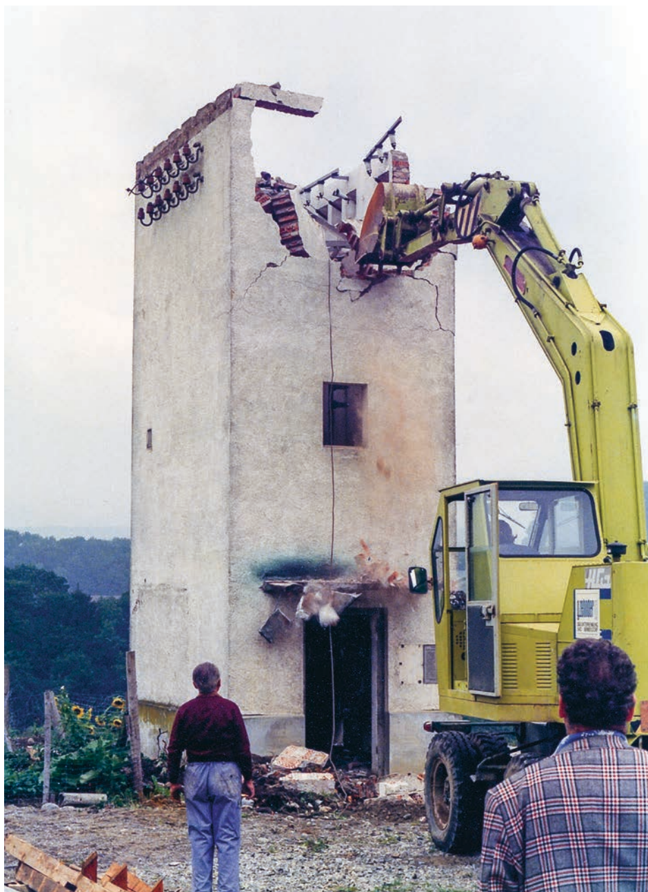
Der alten Trafostation Dorf geht es an den Kragen. Die Turmstation aus dem Jahr 1911 wurde im August 1975 abgerissen, nachdem im Jahr zuvor in unmittelbarer Nähe eine Anlage mit höherer Leistung errichtet wurde. Eine fast identische Turmstation vom Typ «VK 18 Karliturm» ist noch an der Kreuzung Bernerweg/ Mellingerstrasse zu bestaunen. (Sammlung Jost Zehnder)
