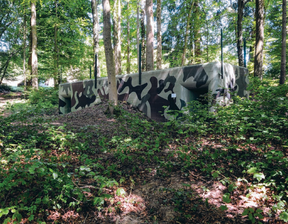
Der Mannschaftsunterstand im Ämmert wurde 1944 zur Verstärkung der Limmatstellung gebaut. Links hinten ist einer der 41 BBB-Blöcke zu erkennen, die in gerader Linie zum Gegenwerk auf Gebenstorfer Boden führen. (Foto Christine Seiler)
