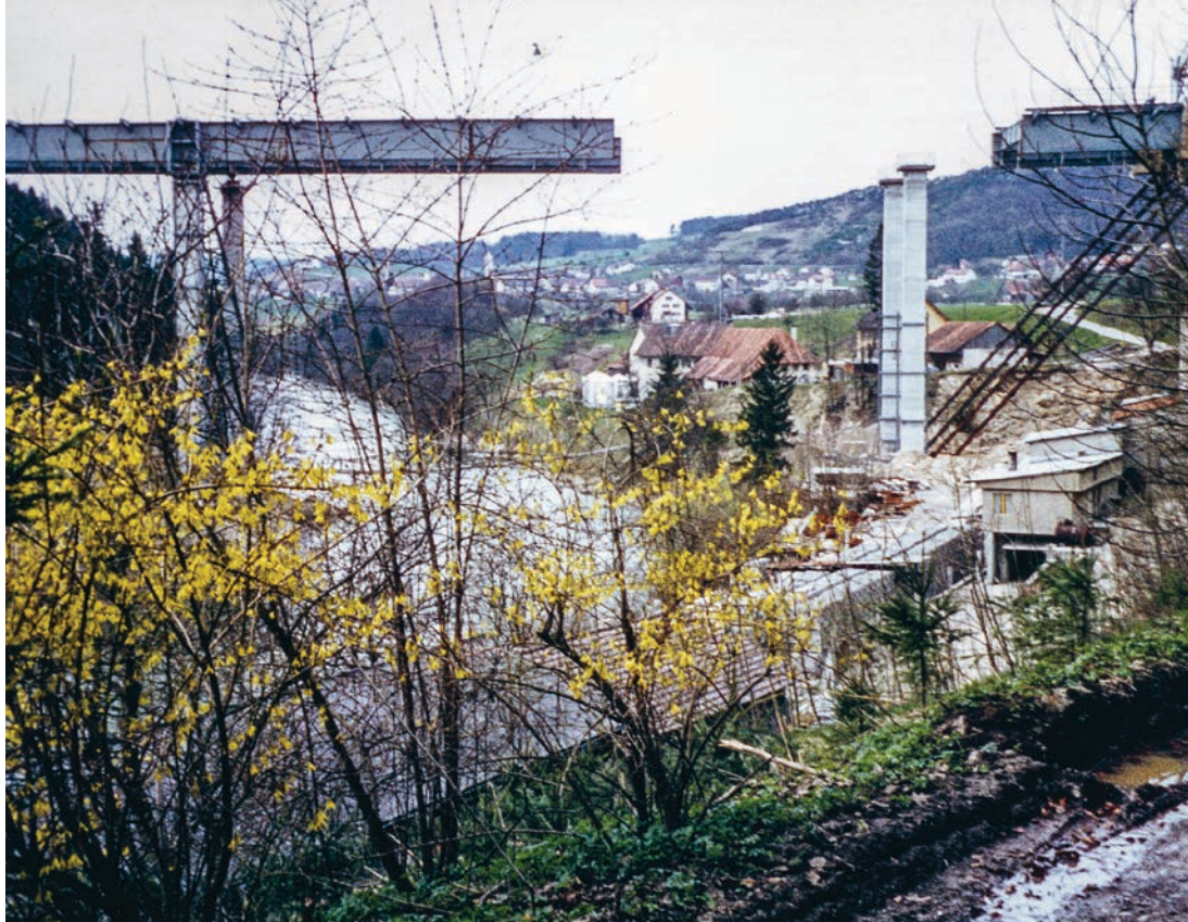
Im Jahr 1968 ist der Nationalstrassenbau durch Birmenstorf schon in vollem Gang. Die Aufnahme zeigt den Reusstalviadukt kurz vor dem Einsetzen des letzten Brückenelementes. (Archiv Max Rudolf)
