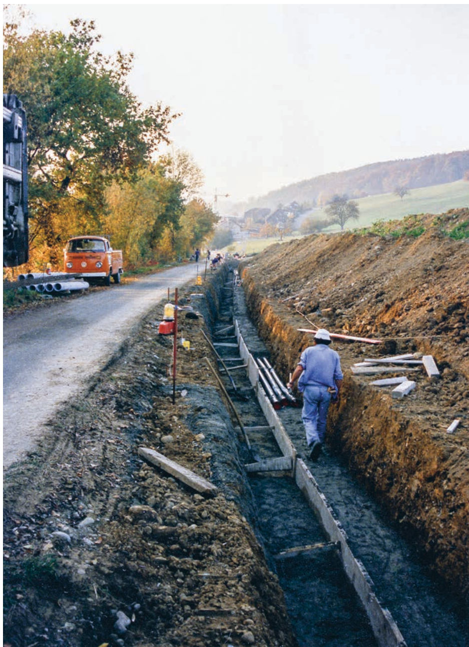
Ein Mitarbeiter der Baufirma G. Zehnder AG in Birmenstorf kontrolliert im Oktober 1989 den Kanal für die Wasserleitung, die vom Segelhof her die Gemeinde mit Badener Trinkwasser versorgen wird. (Sammlung Jost Zehnder)
