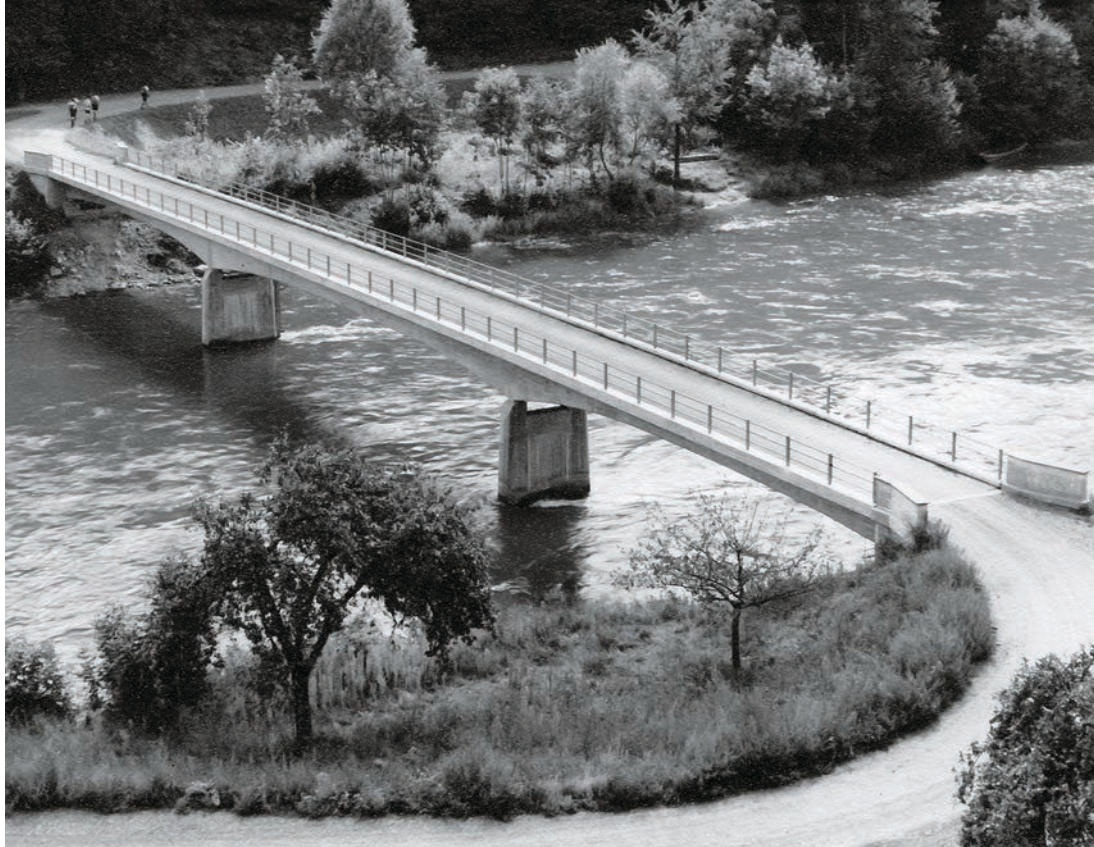
Die Postkarte aus den 1950er-Jahren zeigt die Reussbrücke, die 1949 auf den Widerlagern der alten Holzbrücke neu gebaut wurde. Die alte Holzbrücke, die vom Militär im Zweiten Weltkrieg errichtet wurde, machte die Fähre etwas weiter flussabwärts überflüssig. (Katholisches Pfarrarchiv Birmenstorf)
