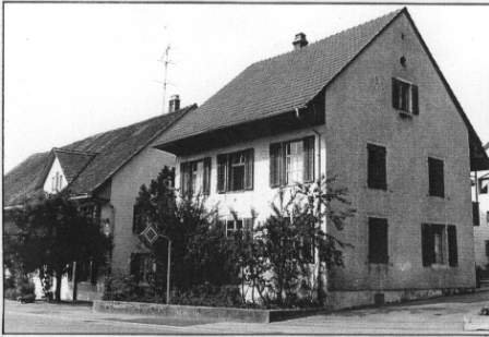
1807 kaufte die reformierte Kirchgemeinde von Sergeant Meier das wenige Jahre zuvor erbaute Wohnhaus und richtete es als Schulhaus ein. 1827 und 1847 wurde es erweitert (Bruggerstrasse 22).
