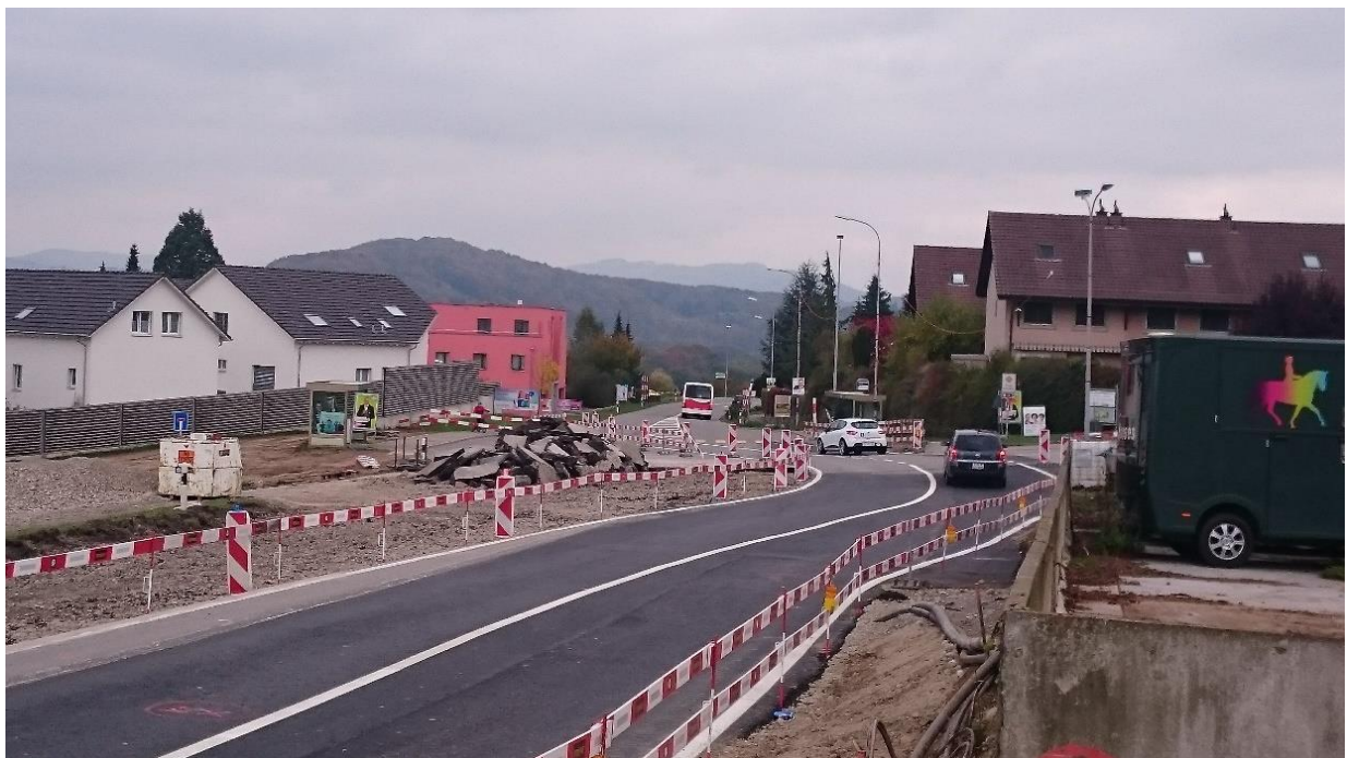
Strassenbaustelle Kreisen Chrüz
