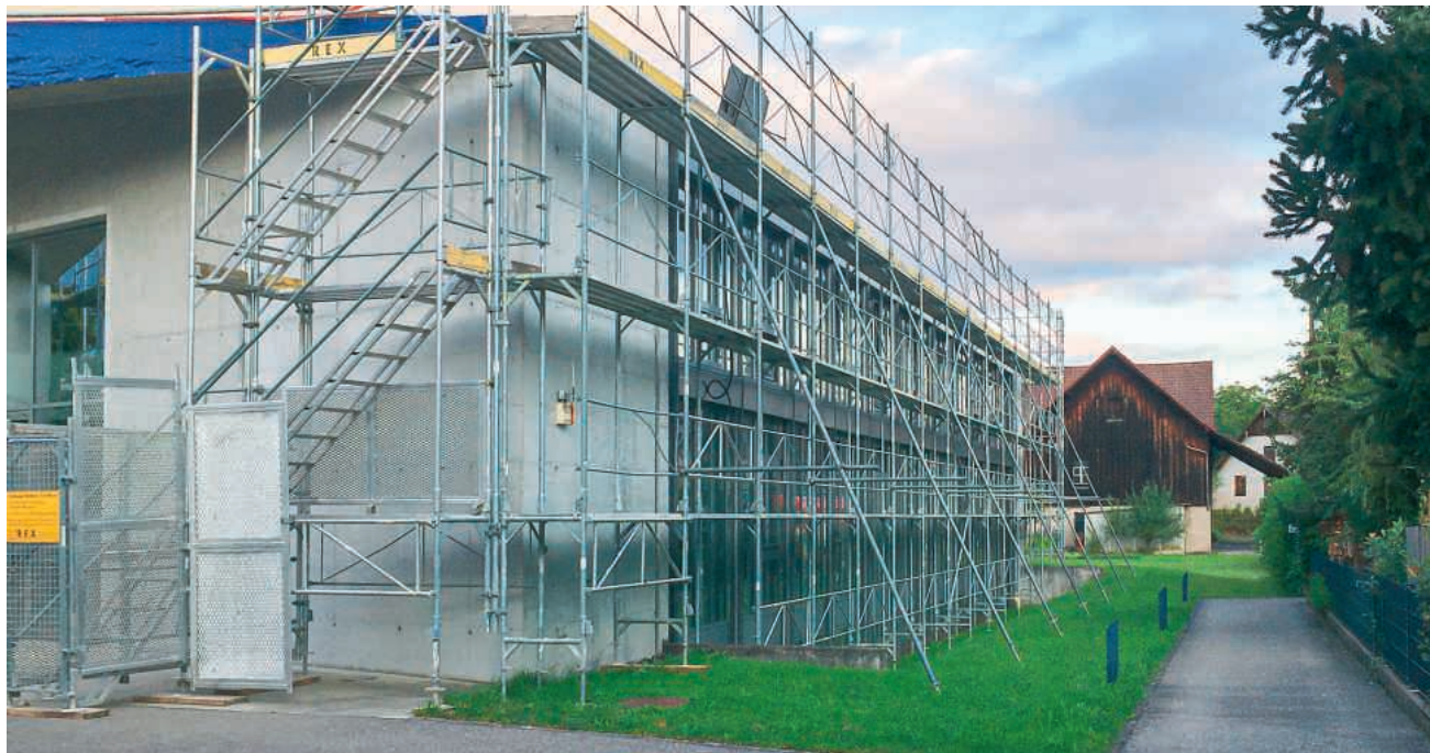
Gerüstet für ein dichtes Dach: Gemeindehaus an der Badenerstrasse
