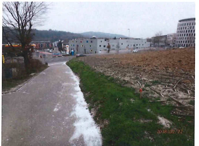
Foto 18: Einfahrtsbereich Ost, beanspruchte Bodenfläche ca. 246 m 2 , Blickrichtung Ost.
