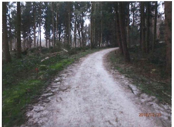
Foto 6: Verbreiterung v.a. westlich des bestehenden Weges (Ausbau Kurvenradius aussen), Blickrichtung Nord.
