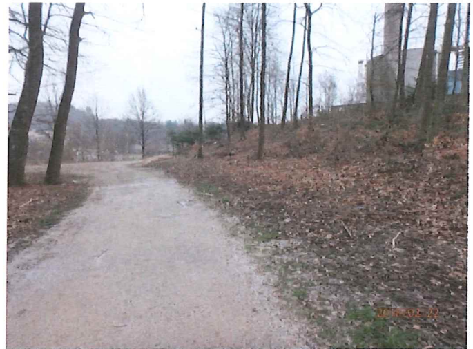
Foto 14: Ausbau Kurvenbereich innen (Begradigung südöstlich), Blickrichtung Nordost.
