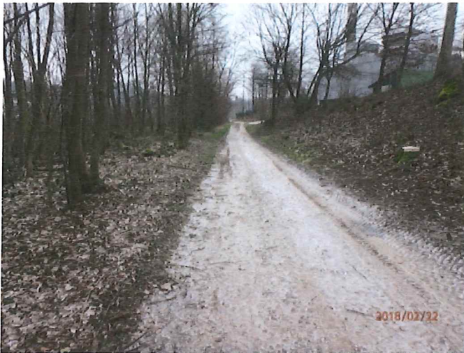
Foto 13: Verbreiterung am Waldrand v.a. nordöstlich des bestehenden Weges, Blickrichtung Nordost.
