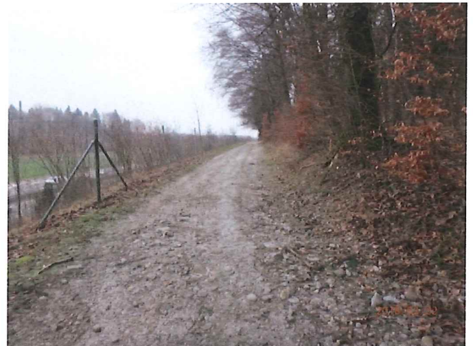
Foto 10: Baupiste im Bereich des bestehenden Weges, Blickrichtung Nordost.
