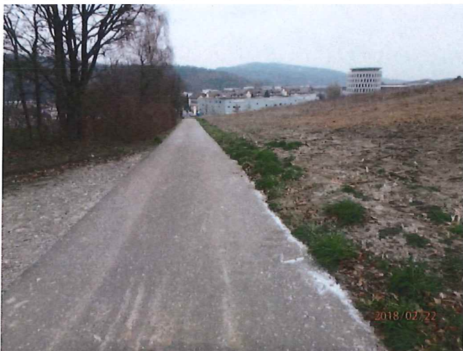
Foto 17: Anpassung bestehende Strasse ohne Bodenabtrag, Blickrichtung Ost.
