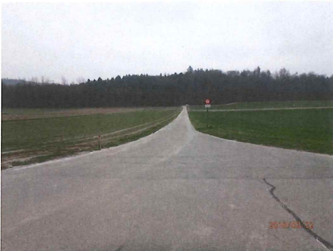
Foto 1: Beginn Baupiste West, Einfahrt von der Sommerhaldenstrasse her, Blickrichtung Nordost.
